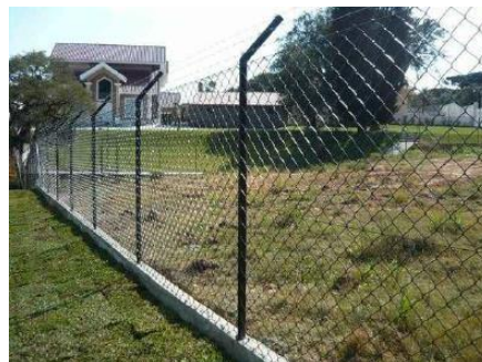
Figura 6 (a+b) - Tipos de cercamento a serem utilizados no aterro (a) Cercamento com moirão de concreto, (b) Cercamento com coluna em tubo de aço.
